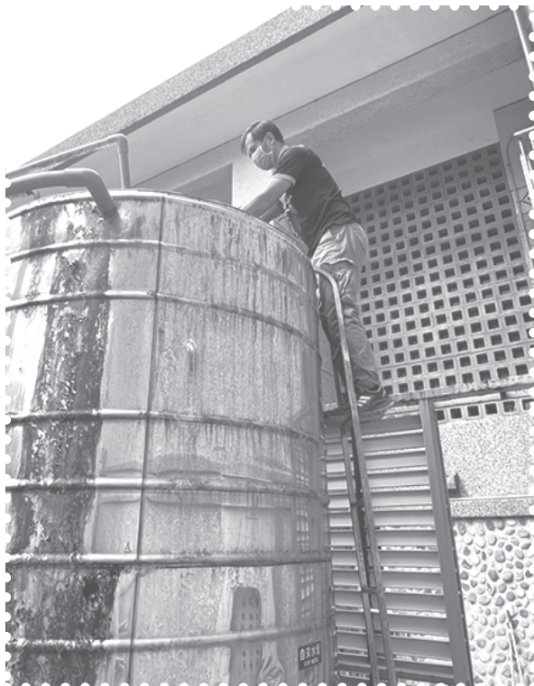
水塔清洗與檢查
