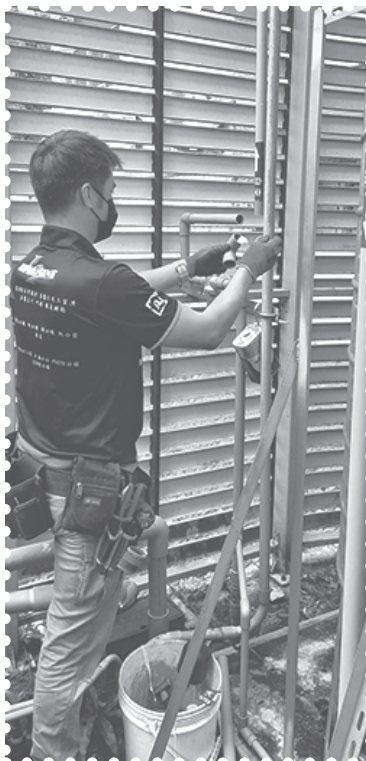
自來水水管改善換新
