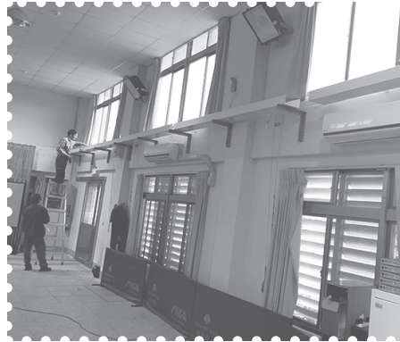
冷氣空調增設
